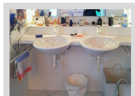
Vor der Renovierung
