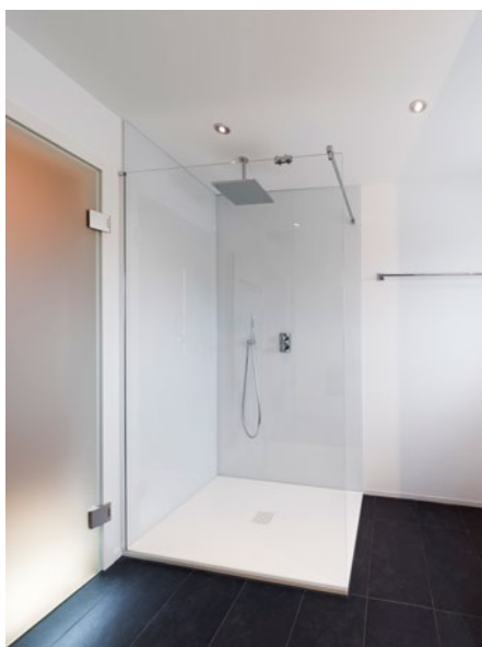
Die Dusche wurde nahezu bodeneben eingebaut. Die Duschwanne ragt kaum in die Höhe.
