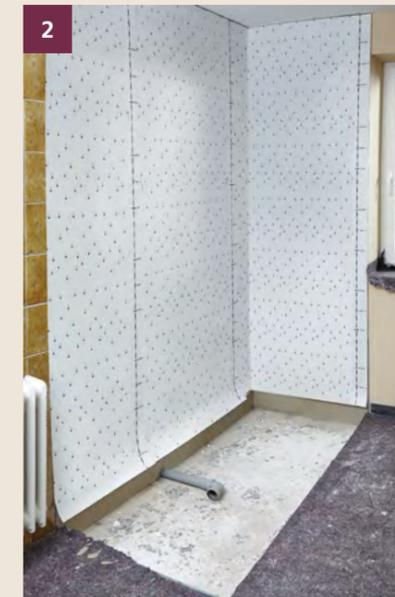
2 Nach dem Prüfen des Untergrunds wird eine neue Abdichtung an der Wand angebracht.
