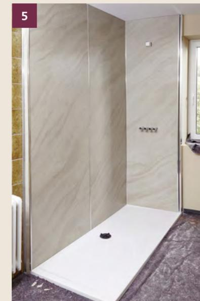
5 Die Innenflächen für die Duschkabine mit „RenoDeco“ von HSK sind eingebaut.
