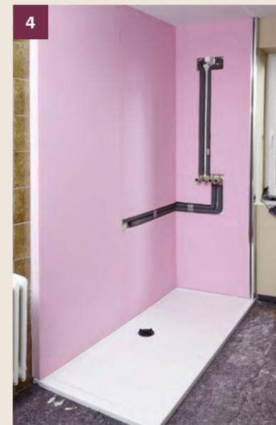
4 Die Trägerplatten für die Verkleidung werden an der Wand angepasst.
