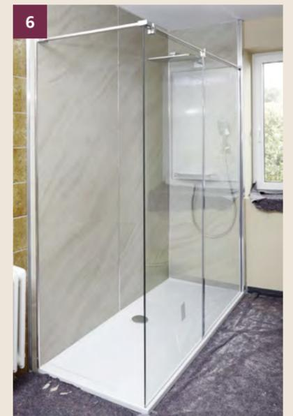
6 Im letzten Schritt wird die neue Duschkabine aus Glaswänden installiert.
